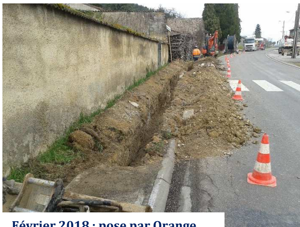
Février 2018 : pose par Orange de la fibre Orange en souterrain y compris le long de la RD 908 vers Heudicourt
