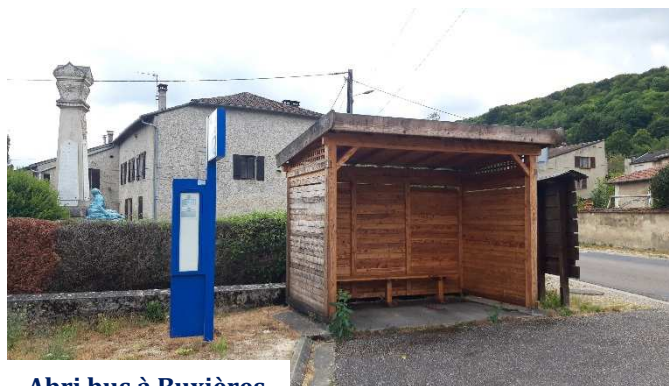
Abri bus à Buxières
