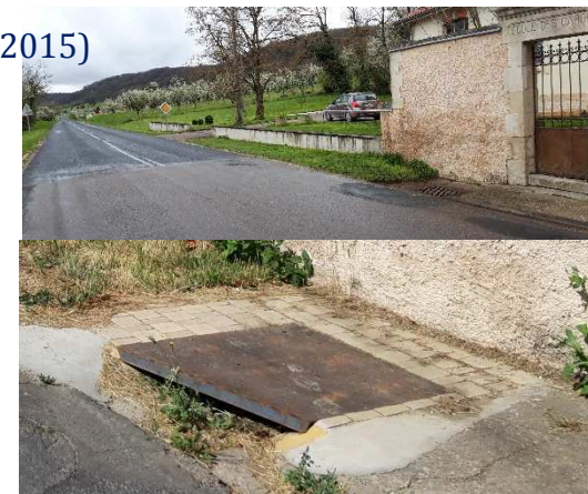
Liaison trottoir /cheminement vers salle Henri Poirson
