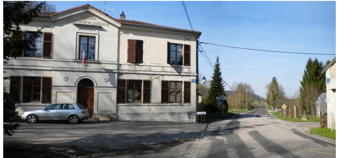
Mairie de Wainville Logements Place des abbés Castillard
